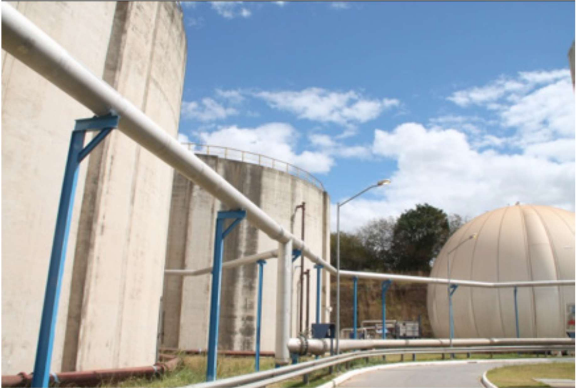
Figura 11 – Biodigestores e gasômetro na ETE Arrudas Fonte: Brasil, 2017
